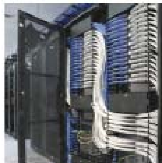
图1. 生产数据中心
